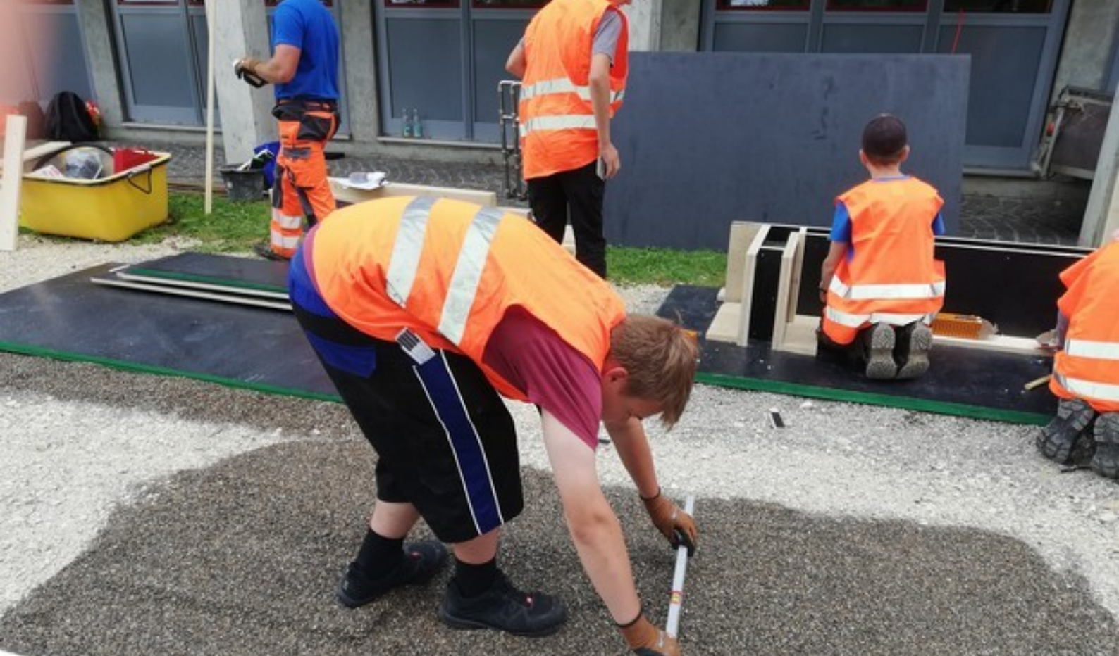
Betonbett (für Schalung)
