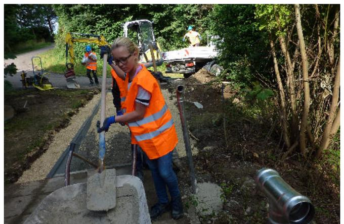
**Wasser hinzugeben** und so lange „umrühren“, bis ein einheitlicher Brei entsteht. Kein Stein und kein Bindemittel soll am Schluss mehr trocken sein.
