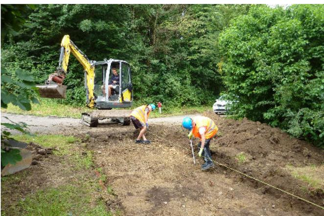
**Ausmessen** für die spätere Einbringung von Beton.
