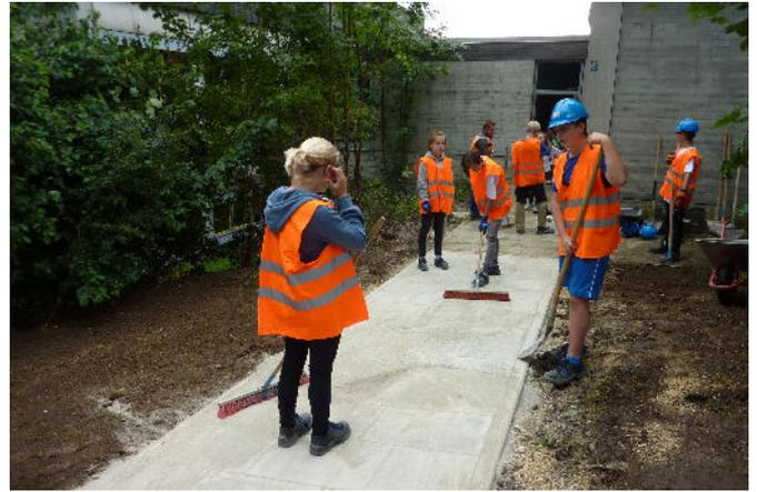
Mit Sand werden die Ränder der einzelnen Betonplatten verfüllt.
