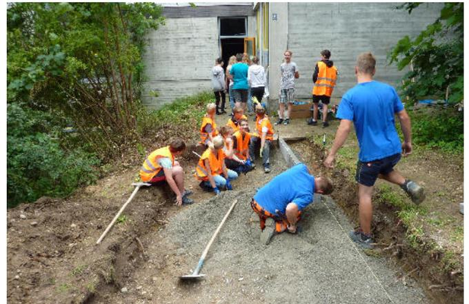
**Beton** wird eingebracht; die ersten Randsteine werden mit der Schnur ausgerichtet.
