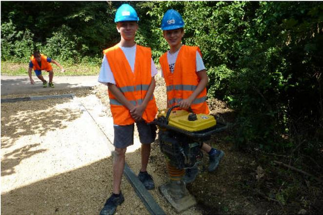
**Der Rüttler** darf von den Schülern nicht bedient werden. Das wäre zu gefährlich. — Mit dem Rüttler wird der Schotter mehrmals verdichtet.
