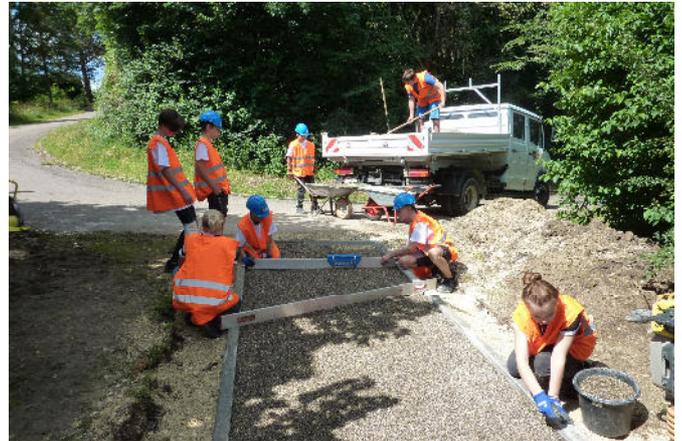
**Eine Lade (Lehre):** Der Splitt wird jetzt so gezogen, dass die Höhe genau auf die Randsteine angepasst wird. Da wir ein Gefälle benötigen, ist die Bettung nicht waagrecht. Das große „Aluminiumbrett“ vorne ist eine lange Wasserwaage. Man sieht, ganz genau, dass die Bettung nicht waagrecht liegt.
