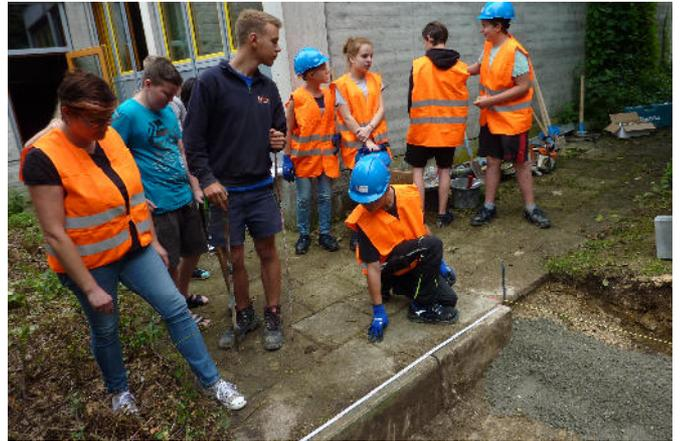
**Ausmessen** für die spätere Setzung der Betonplatten des Gehwegs.
