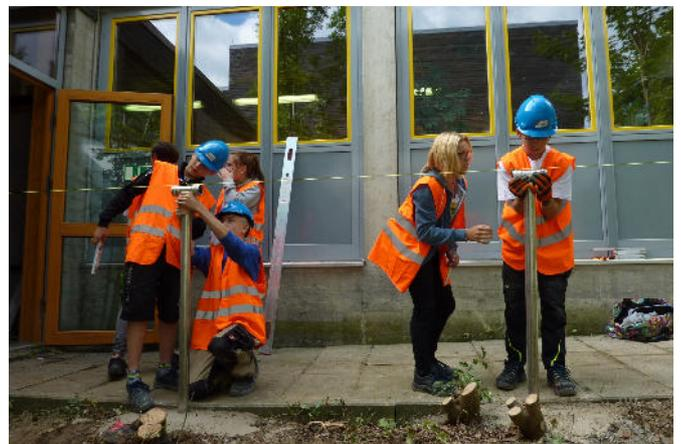
Der Handlauf wird mit Wasserrohren aus Nirostastahl errichtet. Es erfordert millimetergenaues Vorgehen, damit später die Querstangen ohne Probleme gesetzt werden können. Schließlich werden die Rohre mit der Akku-Presser fixiert. Das ist so dauerhaft wie verschweißen.
