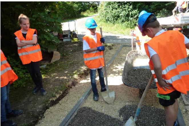
**Die Bettung** wird verteilt. Sie wird nicht mehr verdichtet, muss aber millimetergenau stimmen, damit die zu verlegenden Platten nicht uneben liegen.
